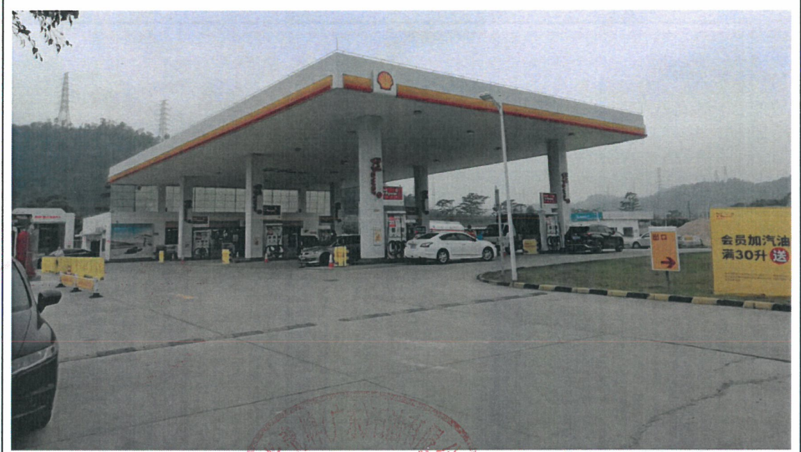
北面：金凤路（主路）、杆高 5m 的架空电力线
